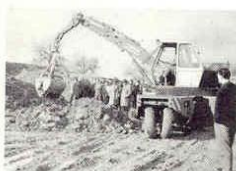
Pourtant la benne 250 litres a pu mettre en valeur sa force de pénétration, à 50 cm sous la surface on rencontrait le sol très dur.
