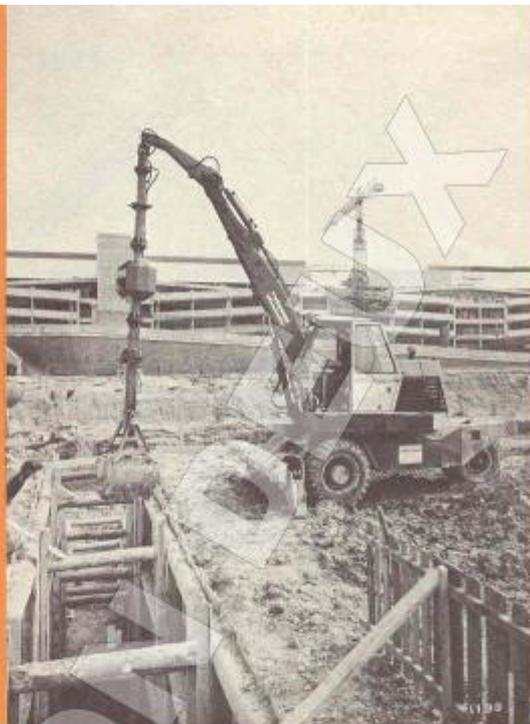
*Porte de Pantin, à Paris, des TY45 de l'entreprise « Union Travaux » exécutent des tranchées profondes entre boisages, pour fondations d'immeubles. Elles sont équipées d'une benne 250 l montée en bout du bâti long, qui avec ses deux rallonges 1 m 30, permet de creuser en puissance et en souplesse jusqu'à 7 m 50 de profondeur. La descente verticale de l'équipement favorise ce travail entre les obstacles.*
