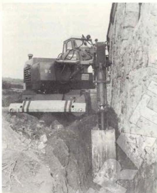
Seule, la benne tranchées se joue de tous les obstacles : tranchées en déporté total, derrière les arbres, en contrebas ou en surplomb, par-dessus un obstacle, etc...
