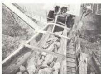
*Les blocs de pierre calcaire passent dans une station de concassage classique.*
