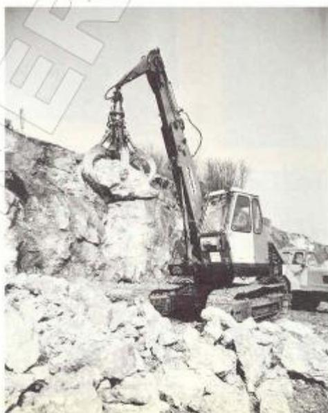
extrêmement dur où elle laisse l'empreinte de ses dents et prépare, par cet abattage, le travail de la seconde qui, équipée d'un chargeur de 400 l, reprend le tas constitué et charge les camions pour approvisionner l'usine de traitement. Le sable subit là les opérations de lavage et criblage par l'installation lavodune. Il va ensuite s'égoutter dans des silos en béton spécialement aménagés, drainés et protégés par une charpente métallique.
