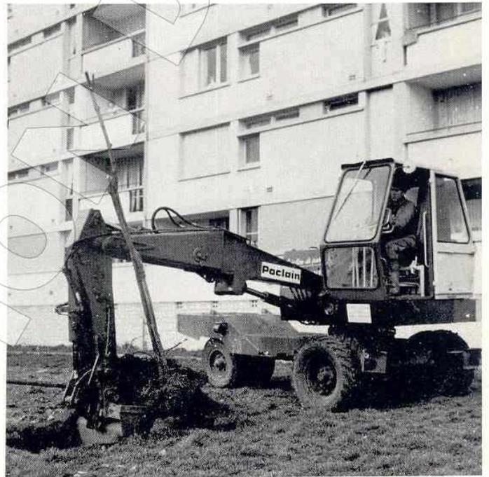
Sa tourelle renfermant le poste de pilotage ainsi que la centrale hydraulique, reçoit une flèche et un balancier standardisés pour la gamme très étendue des équipements que l'on peut y adapter.
